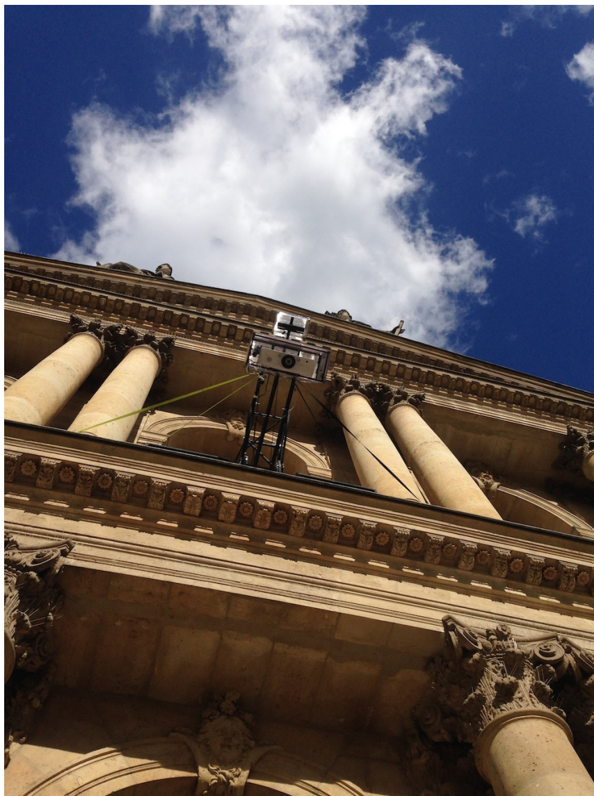
installation de la régie à 8m de haut lors de la Nuit Blanche Paris aux Archives Nationales
